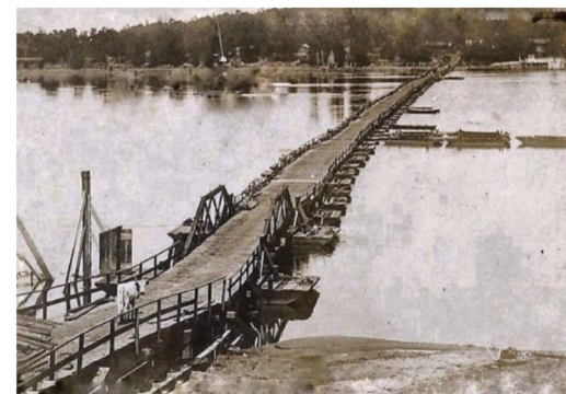
Tak mógł wyglądać most łyżwowy Jagiełły. Grafika przedstawia Arkansas River Pontoon Bridge, najdłuższy tego typu most, jaki zbudowano w USA (prawie 800 m długości), źródło: klubglobtroterawarszawa.com
